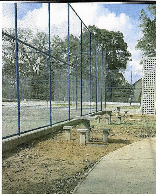
Mesa de jogos em concreto armado.
