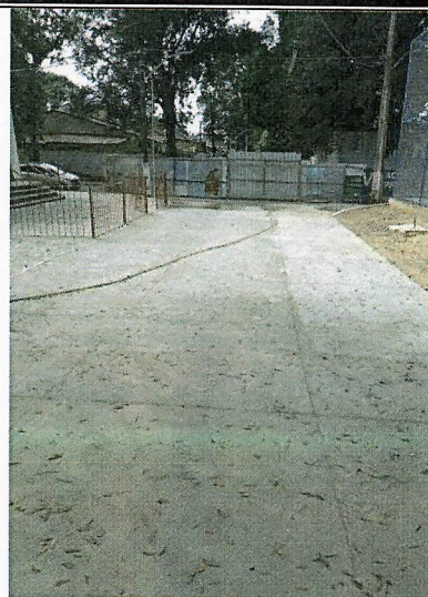
Concreto em frente à igreja.
