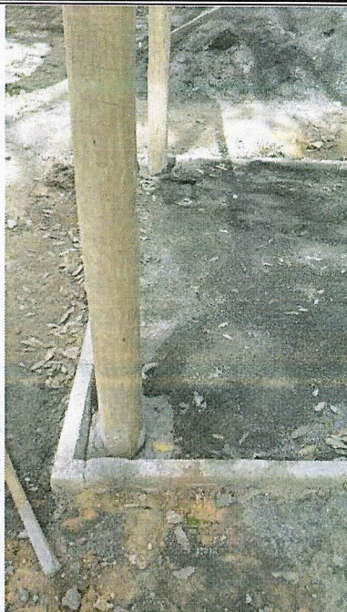
Assentamento de meio-fio na área de piquenique.
