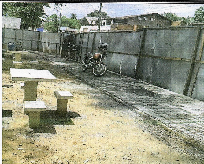
Execução de passeio em piso intertravado.
