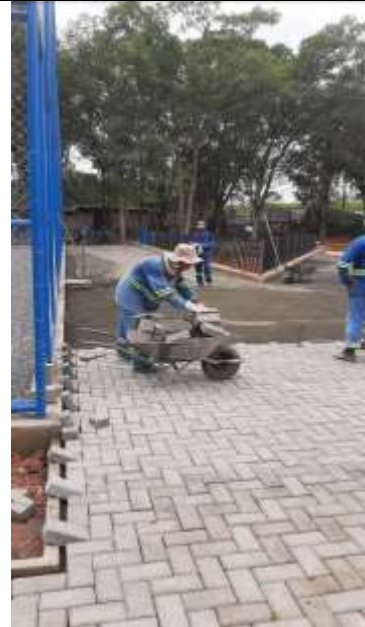
Execução de passeio em piso intertravado.
