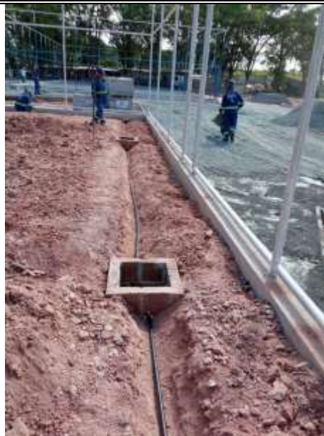
Caixa Pssagem em Alvenaria de Tijolos.
