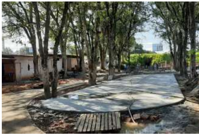
Pista de Patins concretada.
