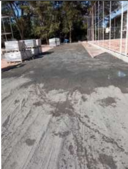
Pó de pedra para assentamento do intertravado.
