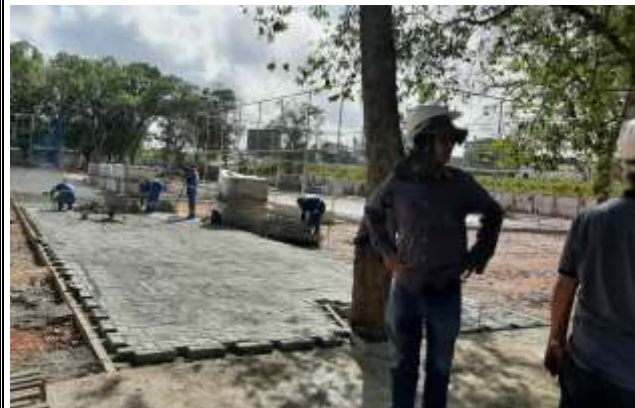
Execução de passeio em intertravado.
