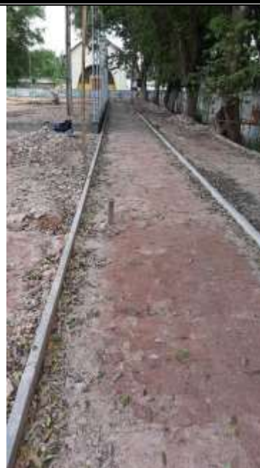
Assentamento de meio-fio da pista de cooper.
