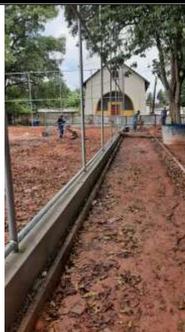
Alvenaria de vedação (Quadra de tênis).
