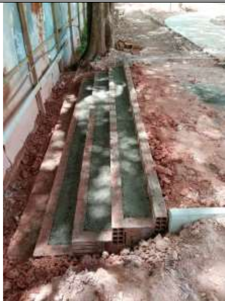
Alvenaria de vedação para degraus de acesso.
