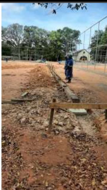
Alvenaria de vedação (Área pet).
