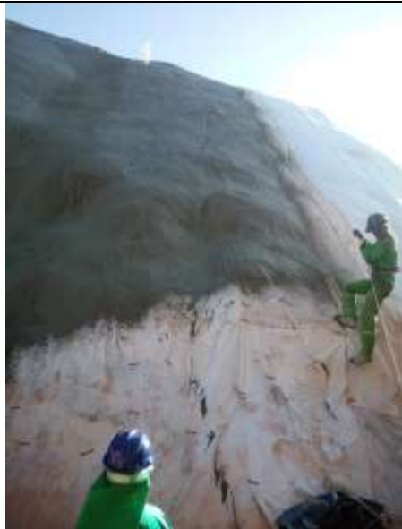
Aplicação de Chapisco – Coqueirinho.
