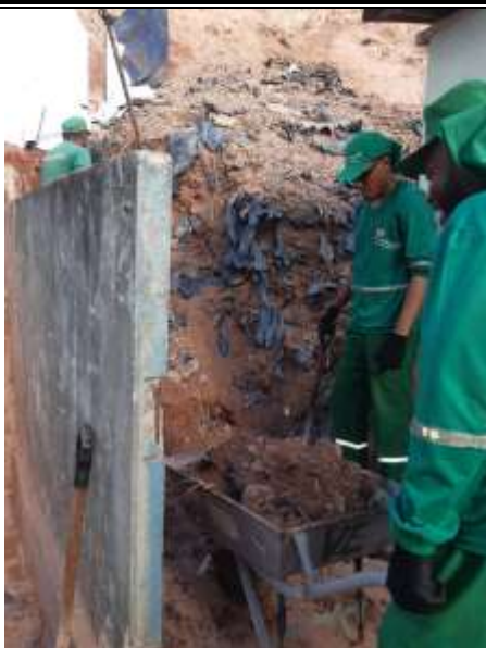
Transporte Horizontal de material retirado da barreira – Coqueirinho.
