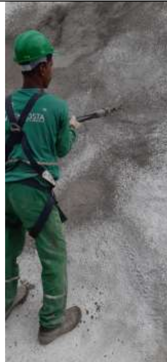
Aplicação de chapisco projetado – Rua Santo Antônio.
