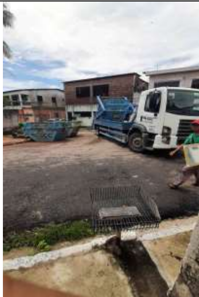
Material Retirado com Caçamba Estacionária – Rua 21 de Abril.
