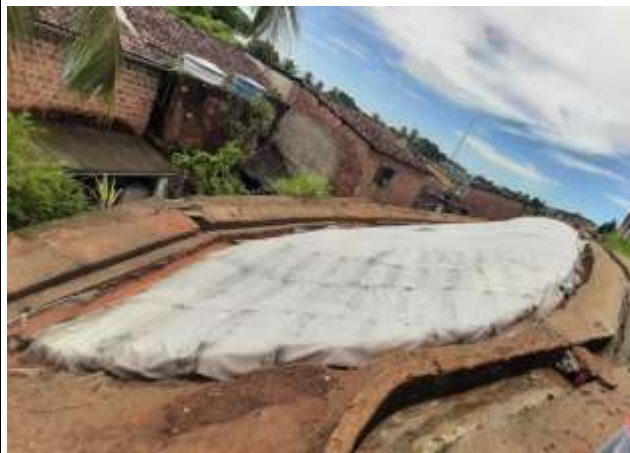
Aplicação de Geocomposto PVC – Rua 21 de Abril.
