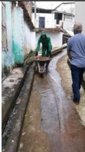
Transporte Horizontal de Material Retirado das Barreiras – Rua 21 de Abril.
