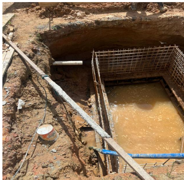
Armação De Estruturas De Concreto Armado, Exceto Vigas, Pilares, Lajes E Fundações, Utilizando Aço Ca-60 De 5,0 Mm - Montagem. Af_12/2015
