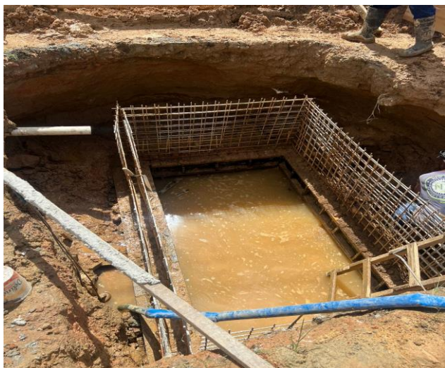
Armação De Estruturas De Concreto Armado, Exceto Vigas, Pilares, Lajes E Fundações, Utilizando Aço Ca-50 De 12,5 Mm - Montagem. Af_12/2015
