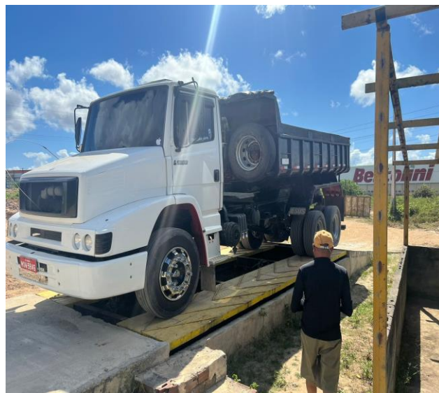
Destinação de material de 1ª categoria proveniente de escavação para Bota Fora.
