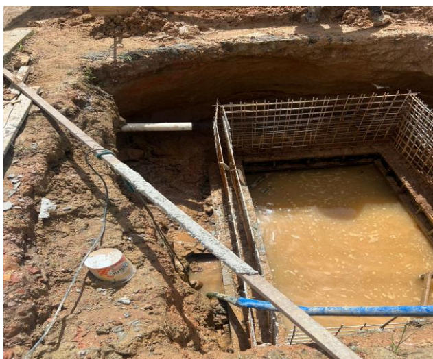
Escavação Mecanizada De Vala Com Prof. Maior Que 1,5 M Até 3,0 M
