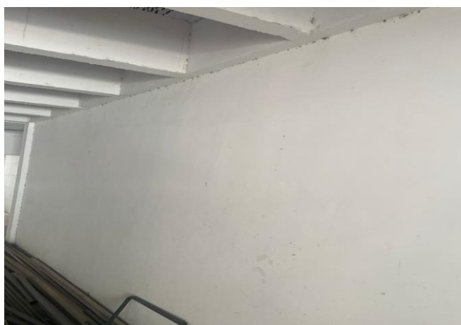
Aplicação E Lixamento De Massa Látex Em Paredes, Uma Demão. Af_06/2014
