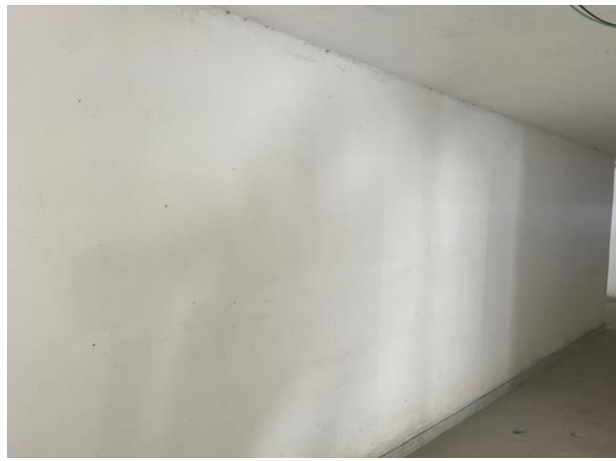
Aplicação E Lixamento De Massa Látex Em Paredes, Uma Demão. Af_06/2014
