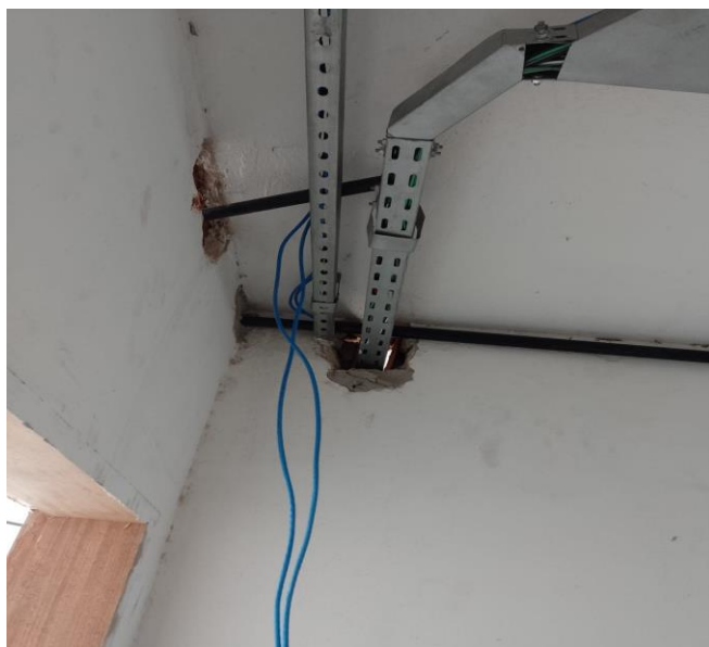
Fornecimento e lançamento de cabo utp 4 pares cat 6 (para cabeamento estruturado).
