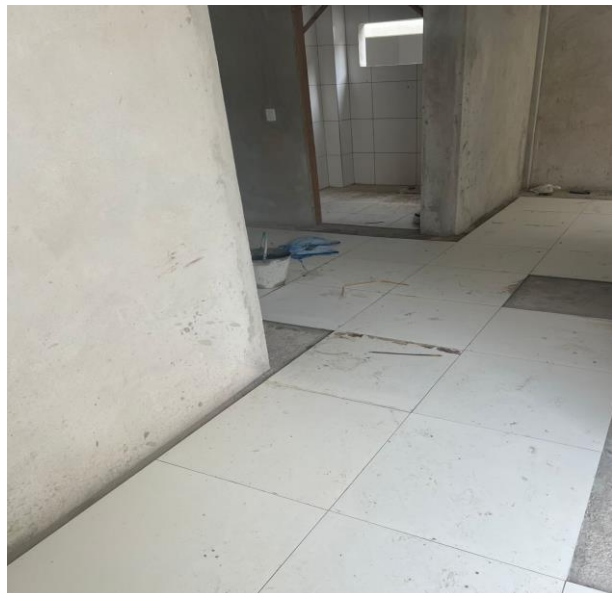
Revestimento Cerâmico Para Piso Com Placas Tipo Porcelanato De Dimensões 60X60 Cm Aplicada Em Ambientes De Área Maior Que 10 M 2 . Af_06/2014
