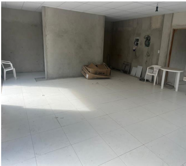
Revestimento Cerâmico Para Piso Com Placas Tipo Porcelanato De Dimensões 60X60 Cm Aplicada Em Ambientes De Área Maior Que 10 M 2 . Af_06/2014
