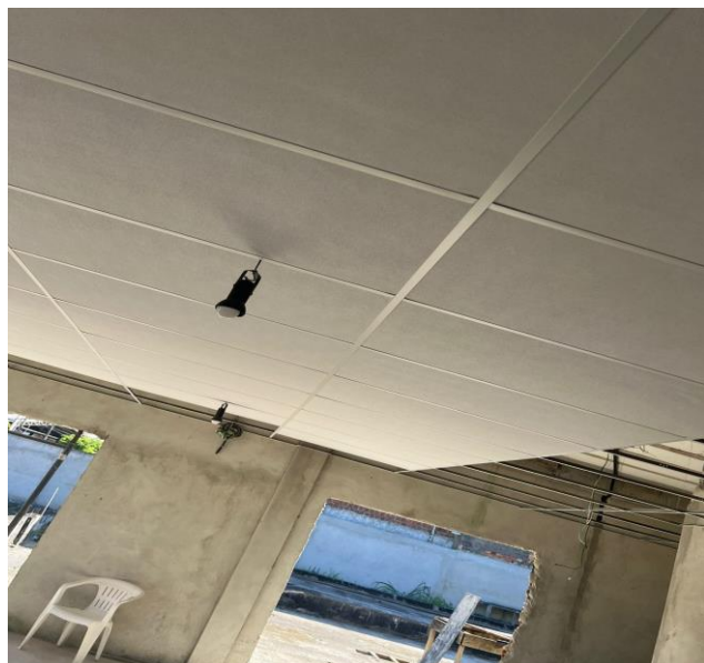
Forro acústico por painéis de lã de vidro revestidos em Pvc de micro perfurado.
