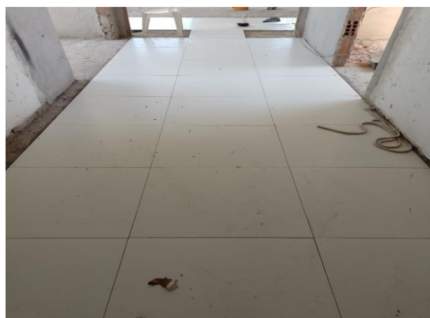
Revestimento Cerâmico Para Piso Com Placas Tipo Porcelanato De Dimensões 60X60 Cm Aplicada Em Ambientes De Área Maior Que 10 M 2 . Af_06/2014
