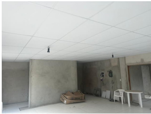
Forro acústico por painéis de lã de vidro revestidos em Pvc de micro perfurado.
