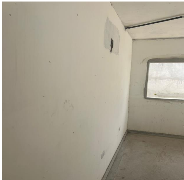
Aplicação De Fundo Selador Acrílico Em Paredes, Uma Demão.
