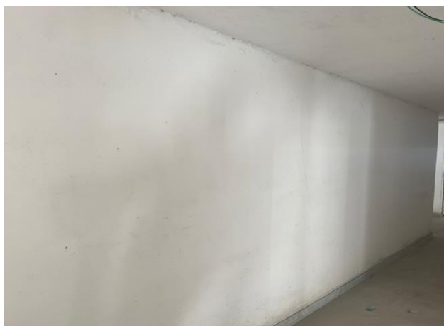
Lixamento manual c/ lixa calafate de concreto aparente antigo.
