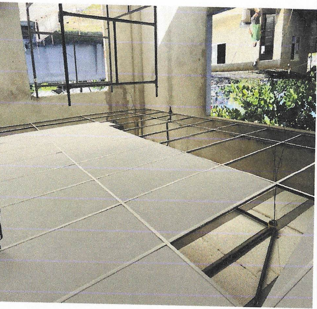
Forro acústico por painéis de la de vidro revestidos em Pvc de micro perfurado.
