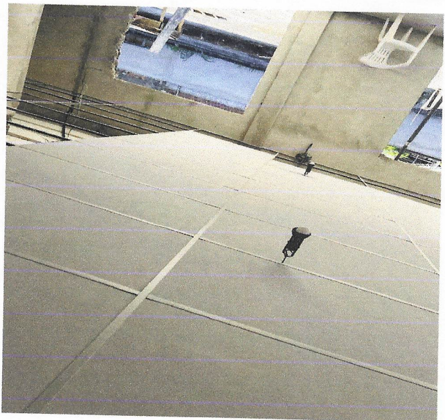
Forro acústico por painéis de la de vidro revestidos em Pvc de micro perfurado.
