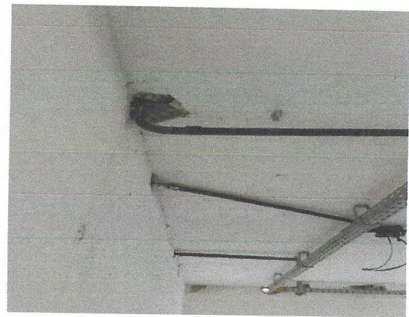
Curva 90 Graus Para Eletroduto, Pvc, Roscável, Dn 60 Mm (2") - Fornecimento E Instalação. Af 12/2015
