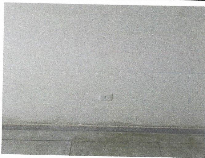
Tomada Baixa De Embutir (1 Módulo), 2P+T 10 A, Sem Suporte E Sem Placa - Fornecimento E Instalação. Af 12/2015
