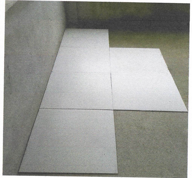
Revestimento Cerâmico Para Piso Com Placas Tipo Porcelanato De Dimensões 60X60. Af_06/2014
