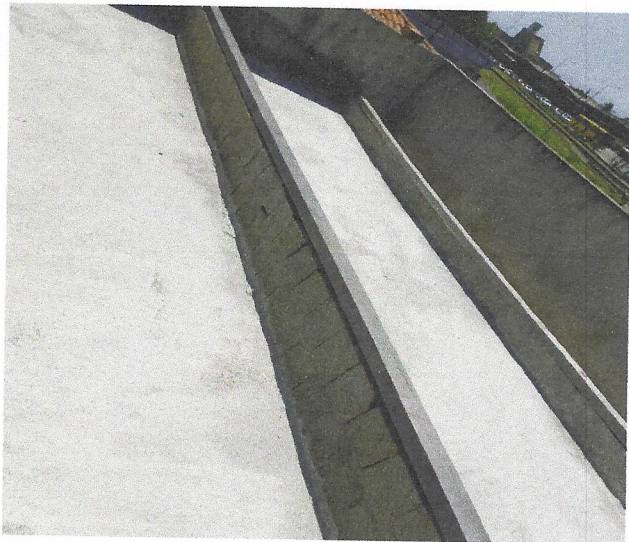
Proteção Mecânica De Superfície Horizontal Com Argamassa De Cimento E Areia, Traço 1:3, E=2Cm. Af 06/2018
