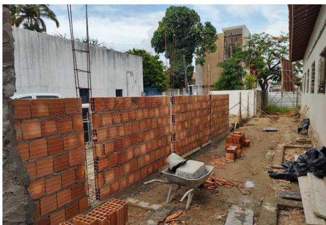
Serviço De Alvenaria De Vedação De Blocos Vazados De Cerâmica De 9X19X19Cm (Espessura 9Cm)
