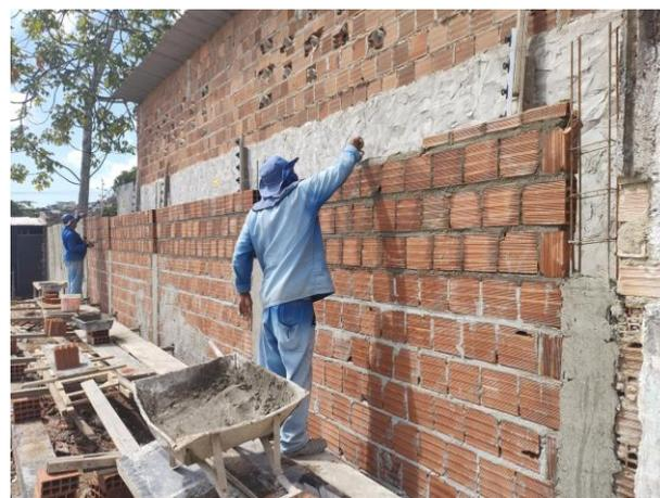
Serviço De Alvenaria De Vedação De Blocos Vazados De Cerâmica De 9X19X19Cm (Espessura 9Cm)
