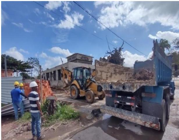
Carga, Manobra E Descarga De Entulho Em Caminhão Basculante 6 M<sup>3</sup> - Carga Com Escavadeira Hidráulica (Caçamba De 0,80 M<sup>3</sup> / 111 Hp)
