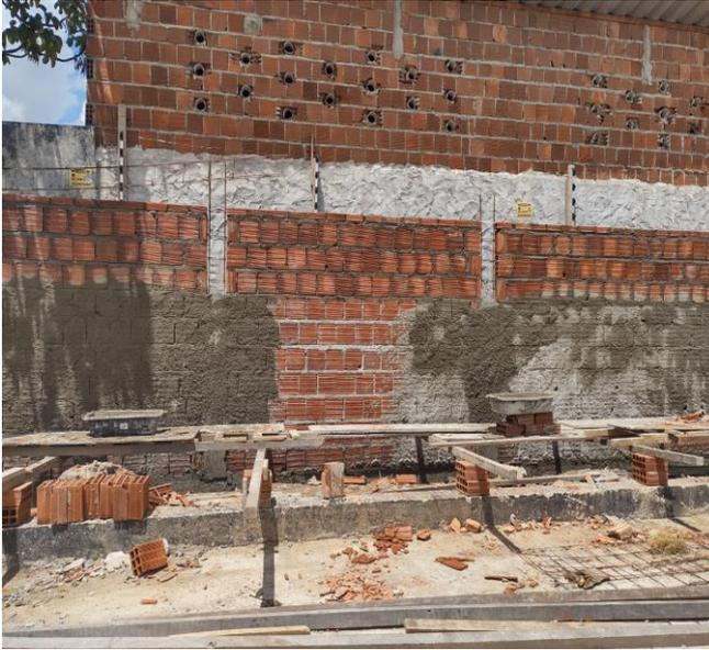
Chapisco Aplicado Em Alvenarias E Estruturas De Concreto Internas, Com Rolo Para Textura Acrílica. Argamassa Traço 1:4 E Emulsão Polimérica (Adesivo)
