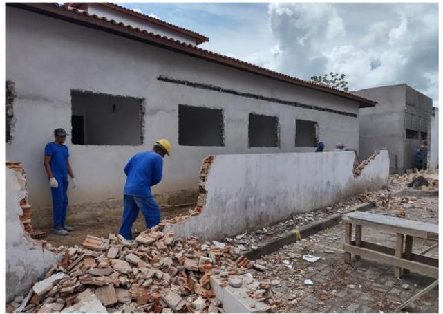
Demolição De Alvenaria Para Qualquer Tipo De Bloco, De Forma Mecanizada, Sem Reaproveitamento. Af\_12/2017
