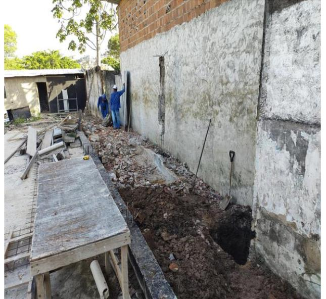
Escavação Manual De Vala Para Viga Baldrame, Com Previsão De Fôrma. Af\_06/2017
