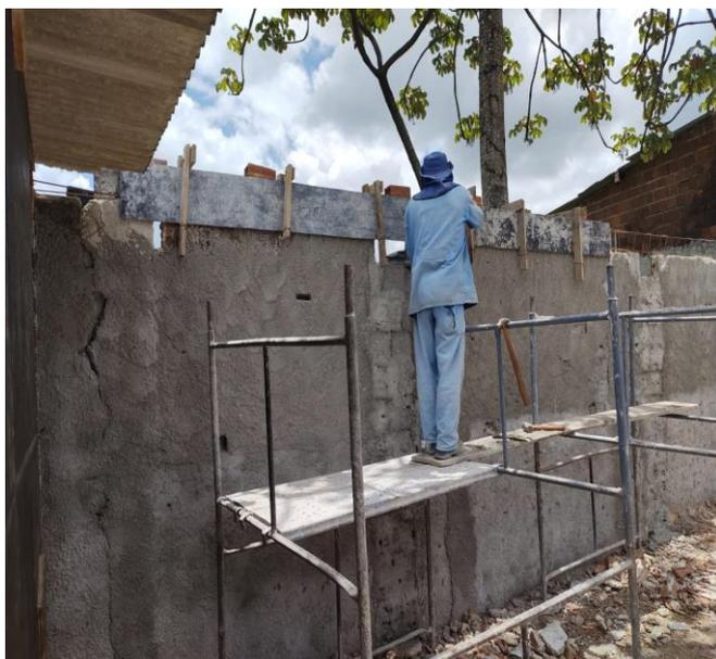
Montagem E Desmontagem De Fôrma De Viga, Escoramento Metálico, Pé-Direito Simples, Em Chapa De Madeira Resinada, 6 Utilizações. Af\_09/2020
