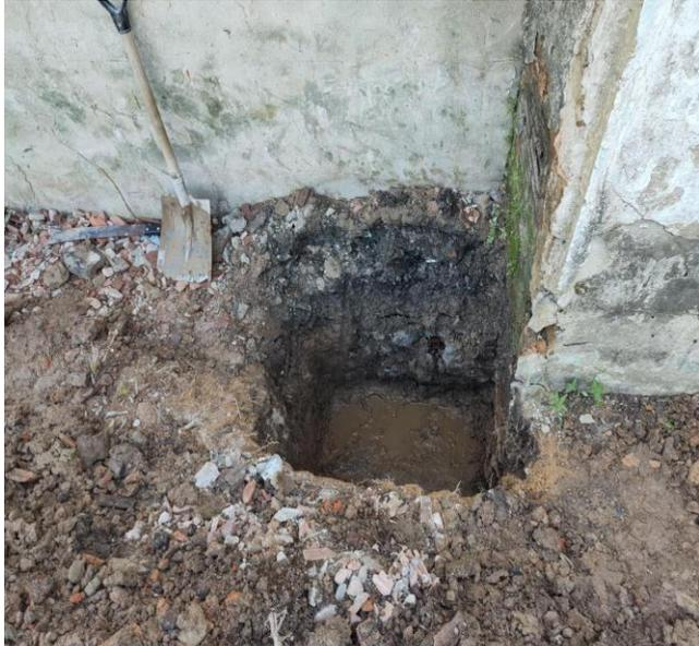
Escavação Manual Para Bloco De Coroamento Ou Sapata, Com Previsão De Fôrma. Af\_06/2017
