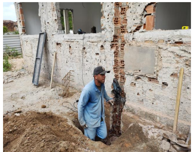
Demolição de alvenaria para qualquer tipo de bloco, de forma mecanizada, sem reaproveitamento.
