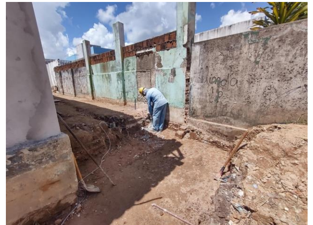
Demolição de pilares e vigas em concreto armado, de forma mecanizada com martelete, sem reaproveitamento.
