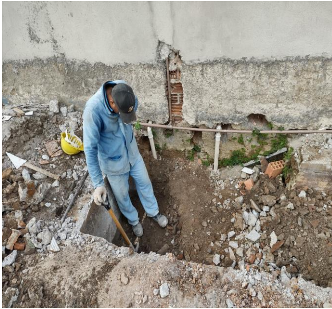
Demolição de alvenaria para qualquer tipo de bloco, de forma mecanizada, sem reaproveitamento.
