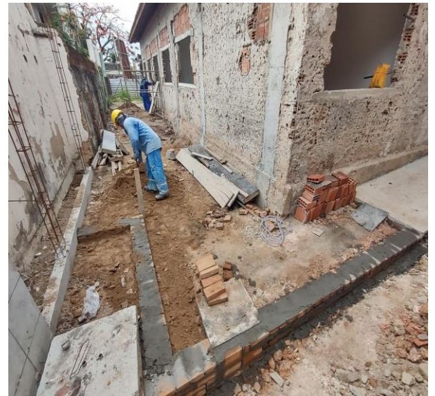
Aterro manual de solo e compactação mecanizada.
