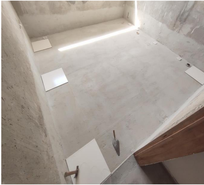
Impermeabilização em superfície com emulsão asfáltica.
