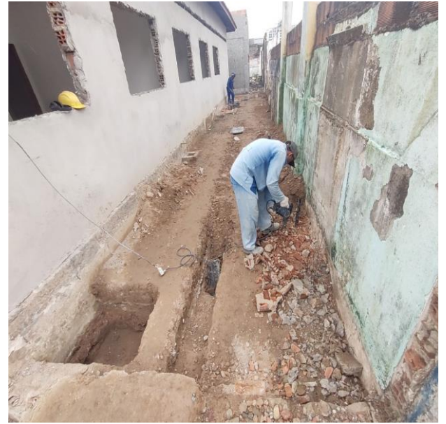
Demolição de pilares e vigas em concreto armado, de forma mecanizada com martelete, sem reaproveitamento.
