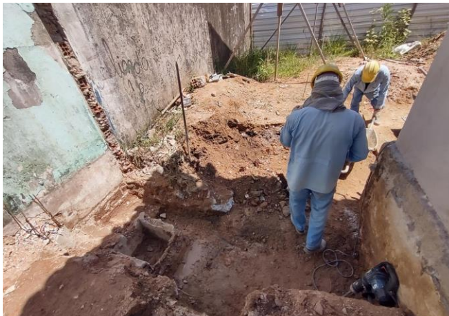
Demolição de alvenaria para qualquer tipo de bloco, de forma mecanizada, sem reaproveitamento.
