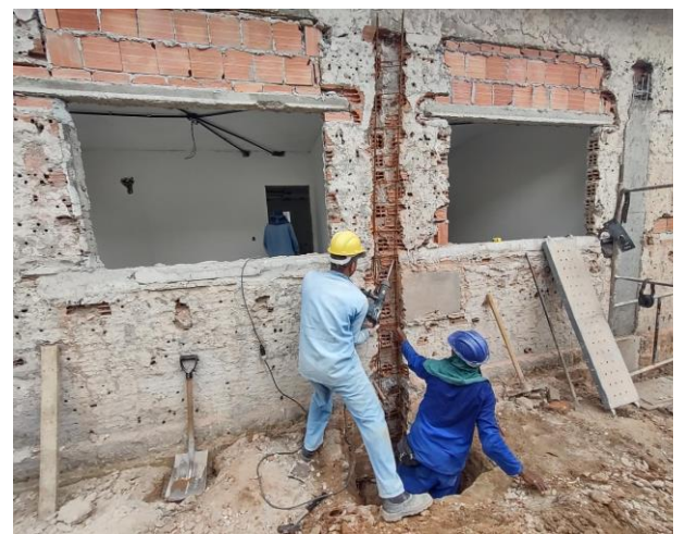
Armação de pilar ou viga de uma estrutura convencional, concreto armado em uma edificação térrea ou sobrado
