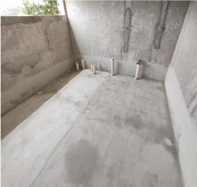
Impermeabilização de Superfície com Emulsão Asfática, 2 Demão.
