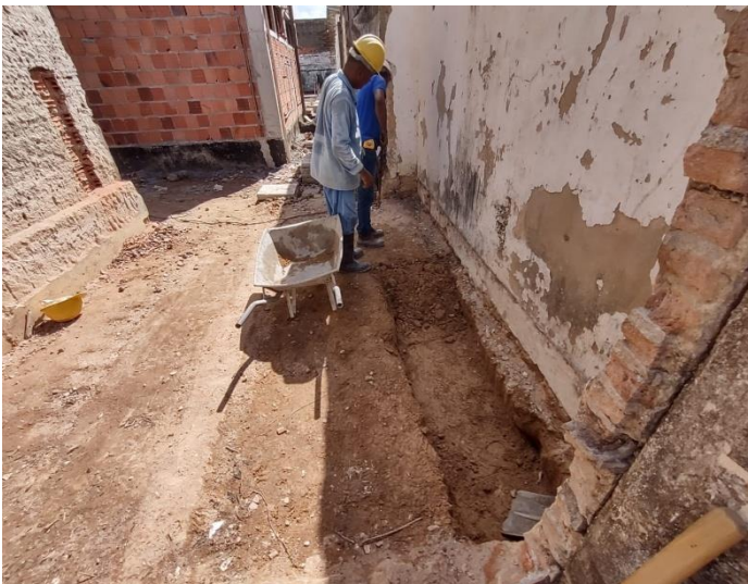
Escavação Manual de Vala para Viga Baldrame, com Previsão de Forma.
