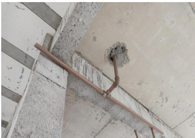
(Composição Representativa) Do Serviço de inst. Tubo PVC, Soldável, Água Fria, DN 25 Mm
