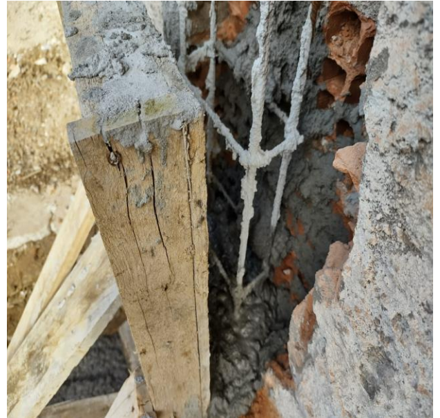
Concreto FcK = 30Mpa, traço 1:2,3:2,7 (Em massa seca de cimento / areia media / brita 1) – preparo mecânico com betoneira.
