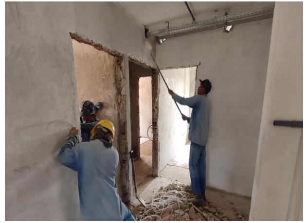
Aplicação de Fundo Selador em Paredes, Uma Demão
