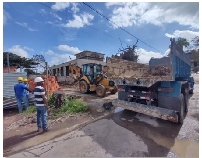
Carga, Manobra e Descarga de Entulho em Caminhão Basculante 6m 3 - Carga com Escavadeira Hidráulica.
