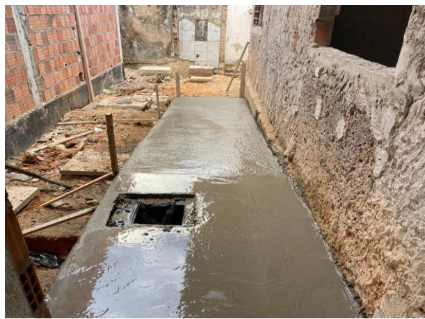
Execução de Passeio (Calçada) ou Piso de Concreto com Concreto Moldado In Loco
