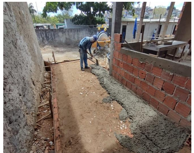
Concreto FcK = 30Mpa, traço 1:2,1:2,5 (Em massa seca de cimento / areia media / brita 1) – preparo mecânico com betoneira.
