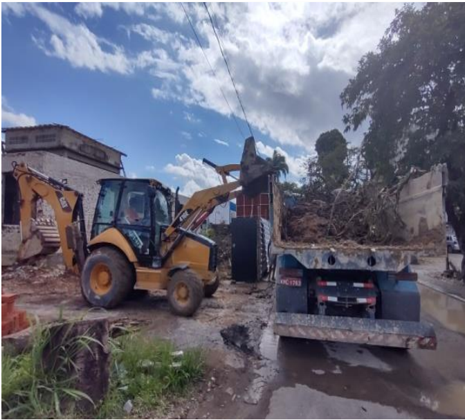
Transporte com Caminhão Basculante de 10 M 3 , em Via Urbana Pavimentada, Dtm até 30km
