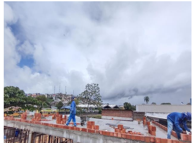
Serviço de Alvenaria de Vedação de Blocos Vazados de Cerâmica de 9x19x19cm
