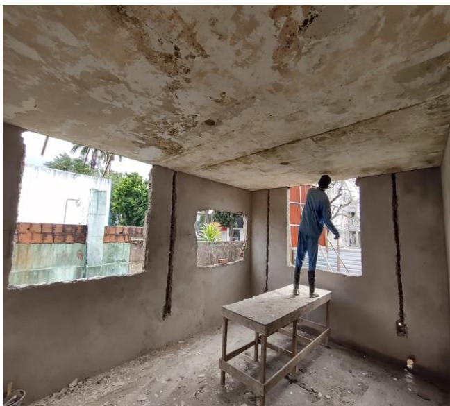
Lixamento Manual com Lixa Calafate de Concreto Aparente Antigo
