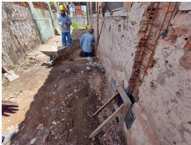
Fabricação, Montagem e Desmontagem de Forma para Sapata, em Madeira Serrada.
