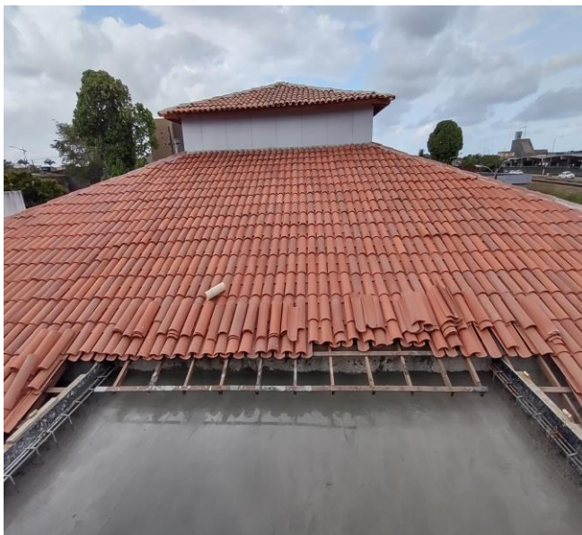
Concreto FcK = 30Mpa, traço 1:2,1:2,5 (Em massa seca de cimento / areia media / brita 1) – preparo mecânico com betoneira
