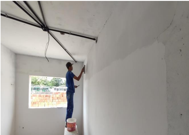
Aplicação e Lixamento de Massa Látex em Paredes, Uma Demão
