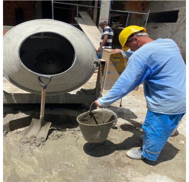
Lançamento com Uso de Baldes, Adensamento e Acabamento de Concreto em Estruturas
