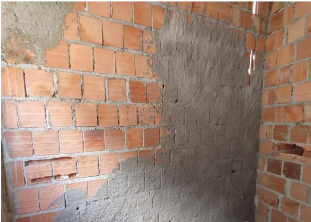
Chapisco Aplicado em Alvenaria e Estrutura de Concreto Internas, com Rolo para Textura Acrílica
