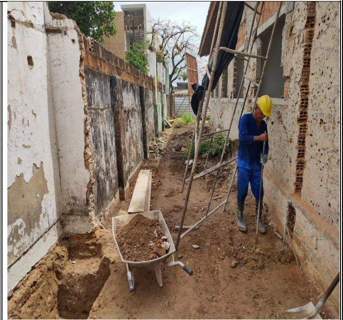
Bloco de Concretamento ou Sapata com Previsão de Forma.
