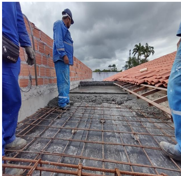
Concreto FcK = 30Mpa, traço 1:2,1:2,5 (Em massa seca de cimento / areia media / brita 1) – preparo mecânico com betoneira
