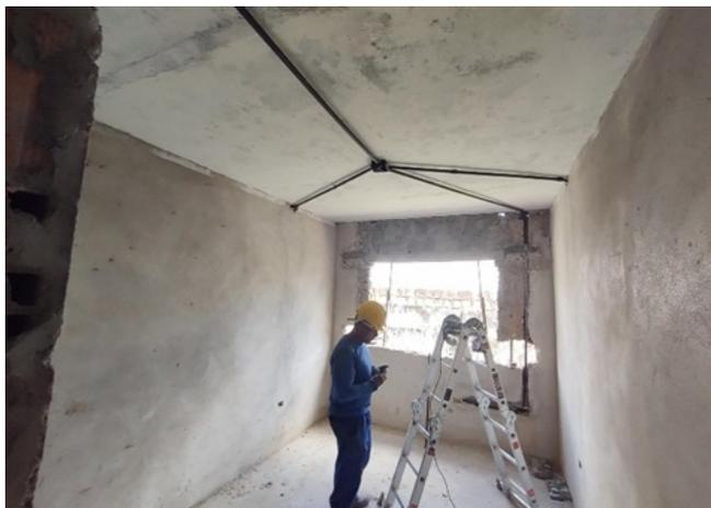
Eletroduto Rígido rosçável,Pvc,Dn 25 Mm(3/4'),para circuitos terminais, instalado em laje- Fornecimento e instalação.
