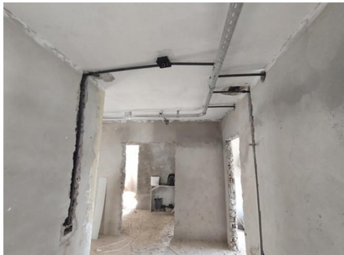
Fornecimento e instalação de eletrocalha perfurada 38 x38 x3000 mm;
