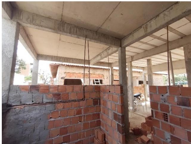
Serviço de Alvenaria de vedação de blocos vazados de cerâmica de 9x19xx9Cm-Foyer
