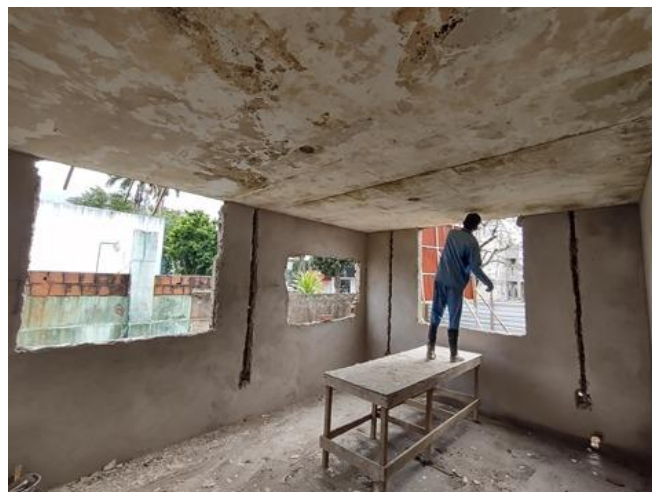
Lixamento manual c/ lixa calafate de concreto aparente antigo. (Área da edificação existente)
