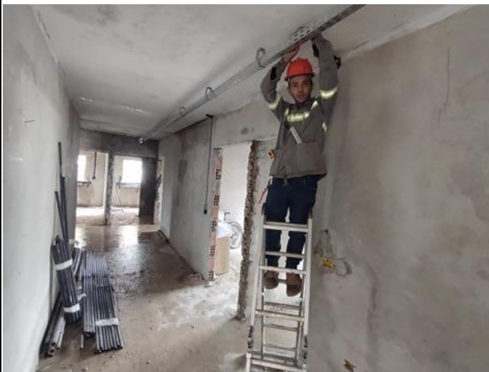
Fornecimento e instalação de eletrocilha metálica 50 x 50 x 3000 mm
