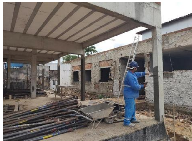
Chapisco Aplicado Em Alvenarias E Estruturas De Concreto Internas.
