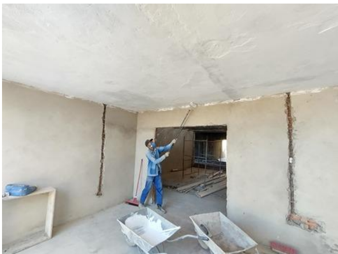
Aplicação De Fundo Selador Acrílico Em Teto, Uma Demão. (Teto)
