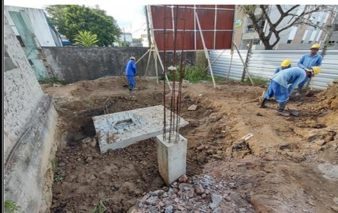
Reaterro Manual De Valas Com Compactação Mecanizada. (Reservatorio)
